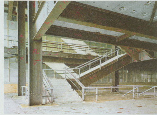
Neben dem Bereich des Volkskammer-saals eignet sich das Palastfoyer für eine Zwischennutzung.
